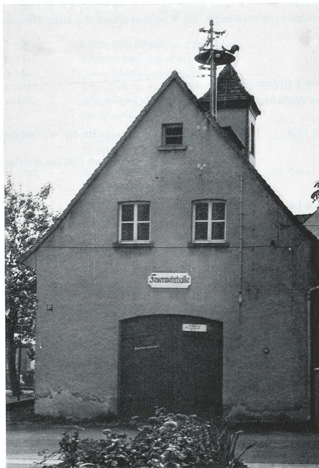
Die Feuerwehrrätehalle mit der Gemeindekanzlei in Tütschengereuth
